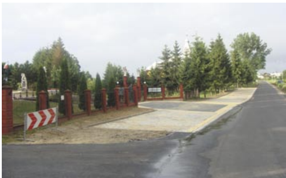
Zmodernizowana droga powiatowa Krowica Hołodowska -Cetynia (fot. K. Witek).
